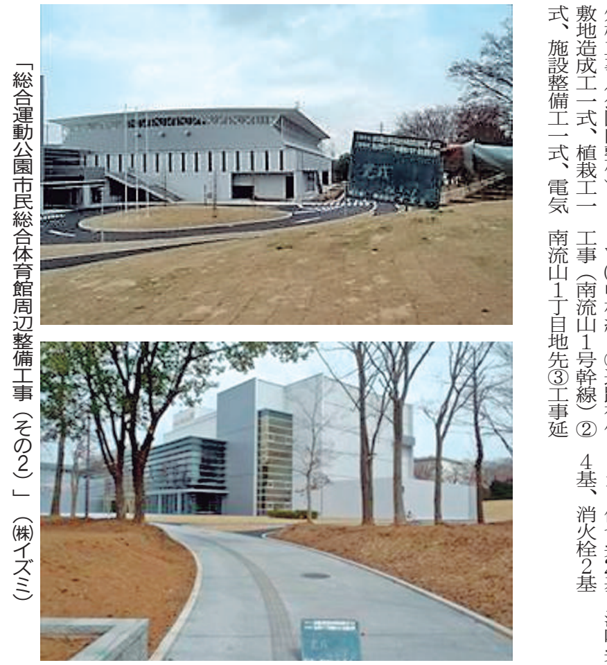
「総合運動公園市民総合体育館周辺整備工事(その2)」(株)イズミ
