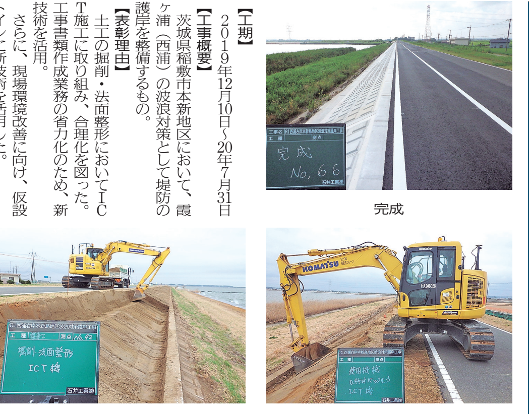
新技術活用実績表彰 R1西浦右岸新島地区波浪対策護岸工事 石井工業株式会社
