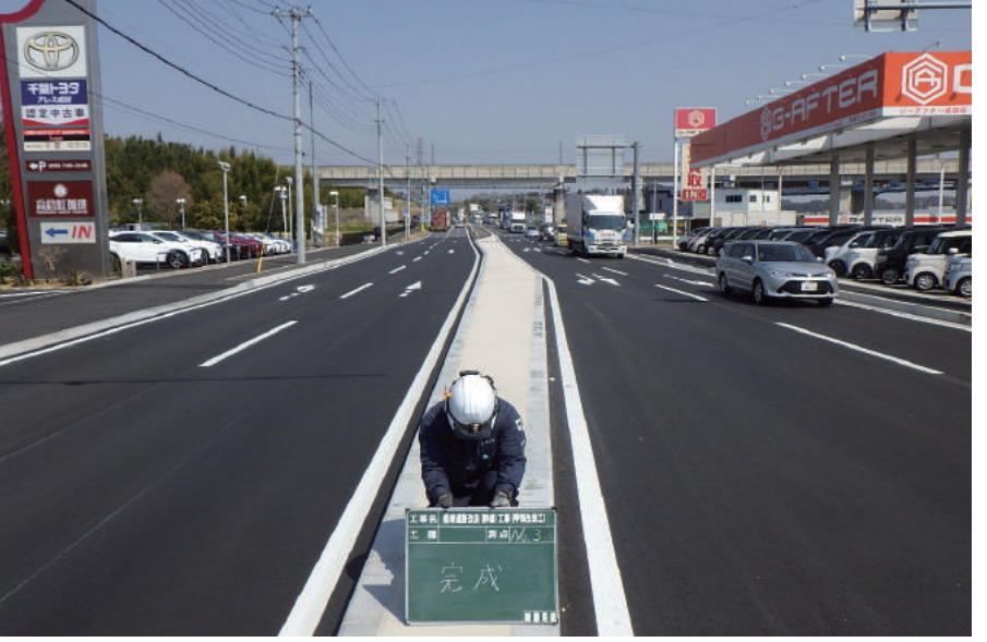
県単道路改良 (幹線) 工事 (押畑改良工)
