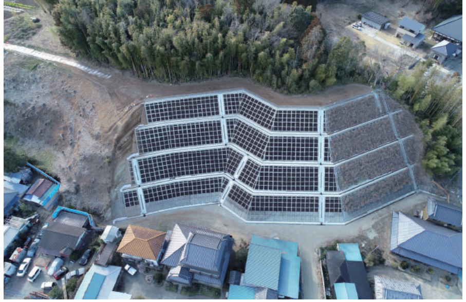
土砂災害防止 (急傾斜) 工事 (辺田その2)
