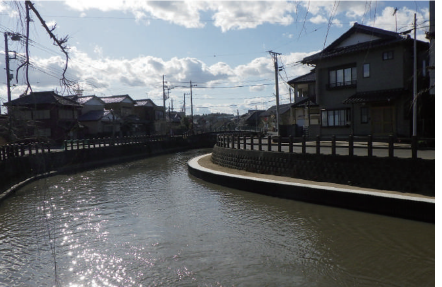
総合流域防災工事 (小野川鋼矢板護岸工その2)
