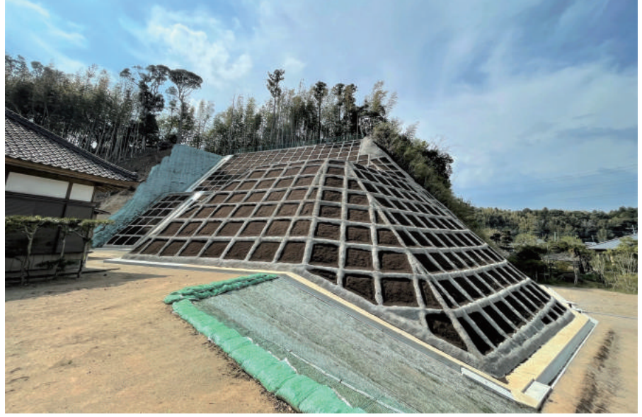
急傾斜地崩壊対策工事 (柴田2 法面保護工)
