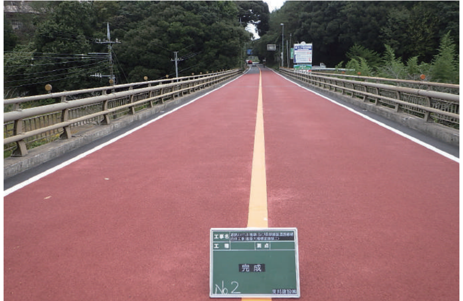
道路メンテナンス (橋梁) 及び 県単舗装道路修繕合併工事 (取香大橋橋面舗装工)
