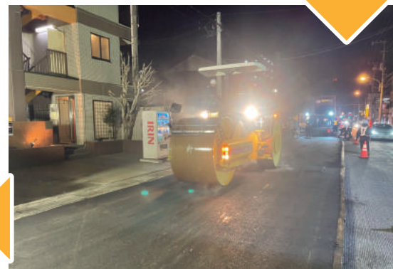
マカダムローラーでの1次転圧(午前2時30分)
