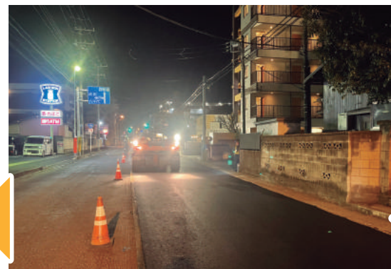
タイヤローラーでの2次転圧(午前3時30分)
