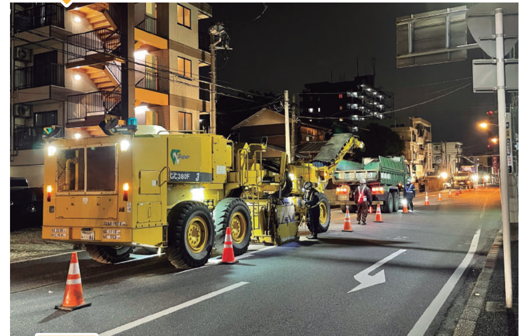
切削機による路面切削開始(午後10時30分)
