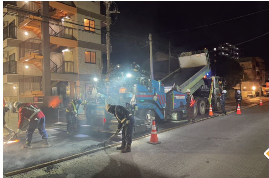
AFフィニッシャーによる舗設(午前1時30分)
