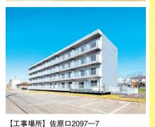
【工種】建築一式 【工期】2020年8月26日~21年9月30日 【請負金額】3億8390万円 【工事概要】1985年建築の市営住宅の改 修および長寿命化。 ▷RC造4階建て、建 築面積401.94㎡、延べ床面積1570.8㎡ ▷ 屋上防水・外壁塗装・金属製建具の改修 室内更新(間取り改修およびユニットバス
