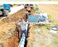
【工事場所】仁良(市道I—51号線) 【工期】2021年3月17日~同年7月4日 【請負金額】1518万円 ル鋳鉄管(GX形) φ300mm・120m ▷配水 用ポリエチレン管(HPPE)φ150mm・
