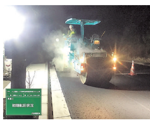
初期転圧施工状況
