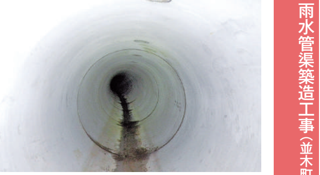
雨水管渠築造工事(並木町大久保台市道流末排水) 株式会社 大松建設
