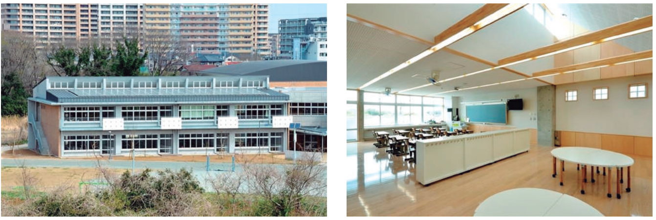
工藤電機工業(株)施工の柏市立柏の葉小学校校舎増築工事(電気設備工事) ⑤増築校舎 ⑥教室照明
