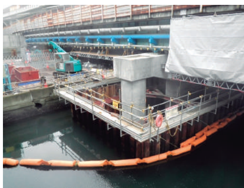
国道357号架橋下部(その1)(東邦建設)
