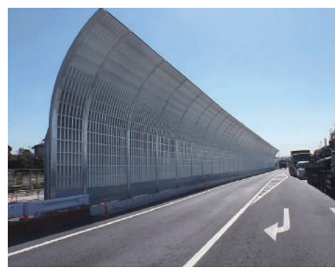
田尻高谷遮音壁その1工事(工建設)
