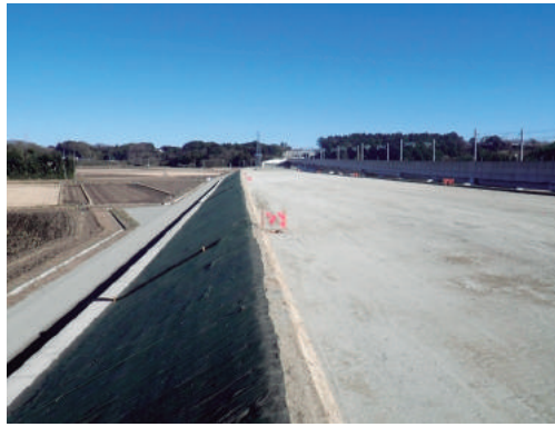
北千葉道路北須賀・押畑地区改良の2(畔蒜工務店)
