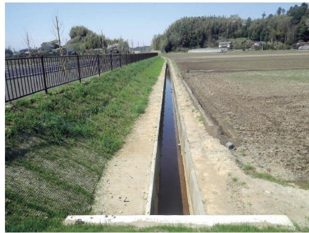
赤坂台方線水路布設替工事 (株)小高興業
